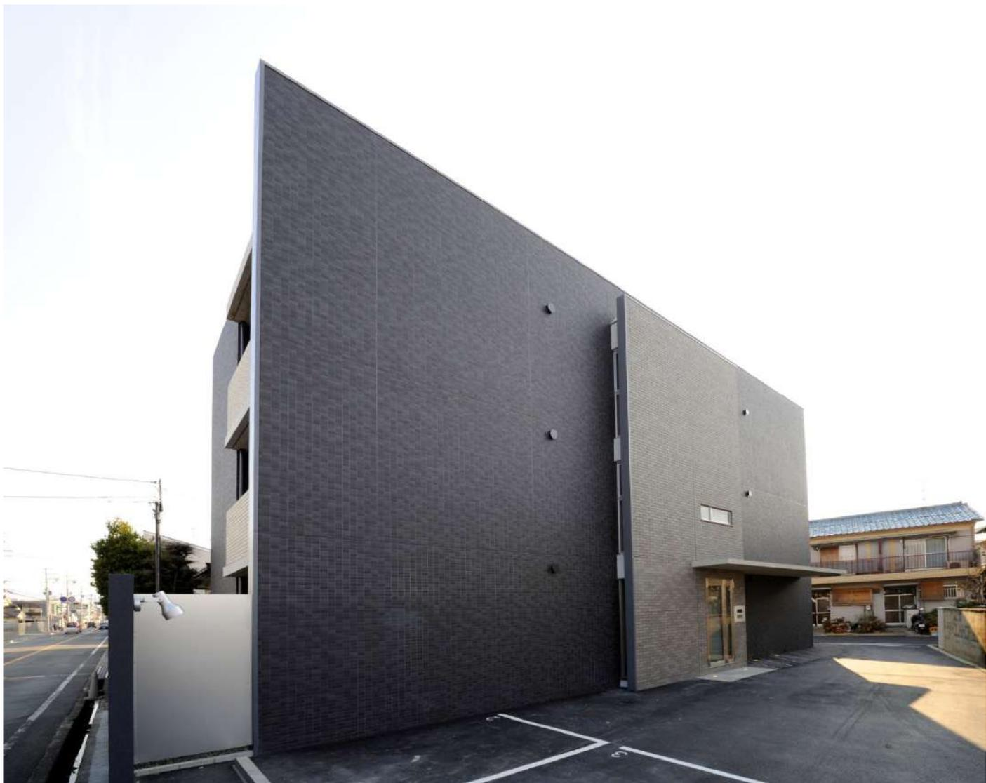
2LDK x 6 戸の集合住宅。オーナー宅である 20squares の隣地に建ち、そのプライバシーを保つため、あえて開口を制限し、面を強調するデザインとした。1 階は入居者のプライバシーと快適性を重視し庭を設け、それに対して大きく開口をとっている。賃貸としての収益性も考慮し共用部は最小限の面積とし、長期一括借上げも実現している。 RC 造 3 階建 延べ面積 338.82 m<sup>2</sup>
